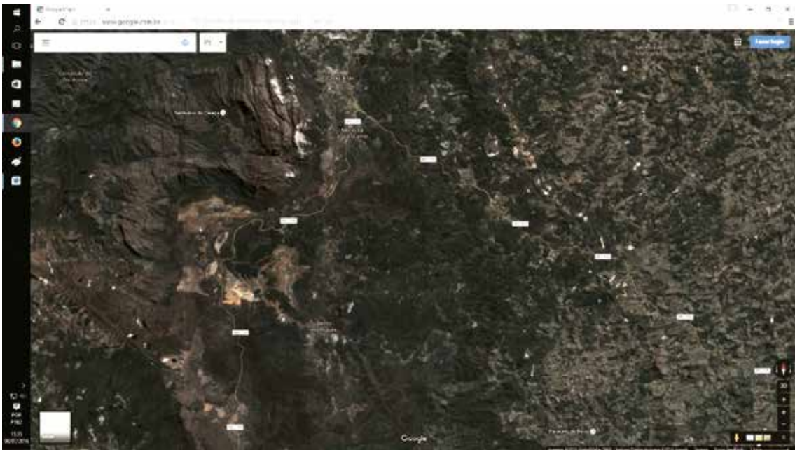
Vista aérea das barragens de rejeitos da Samarco em Bento Rodrigues
