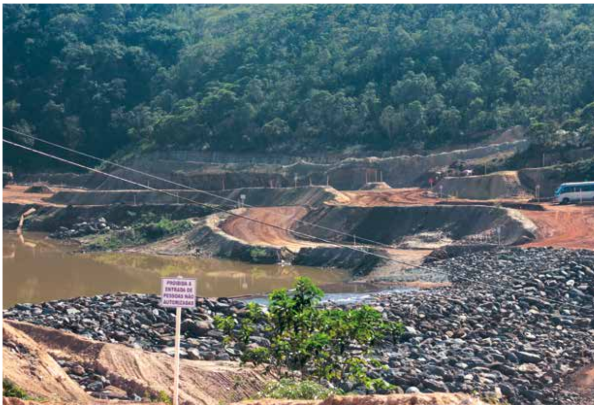
Obras em Bento Rodrigues, julho de 2016 Foto: Fabiana Grassano, arquivo de viagem
