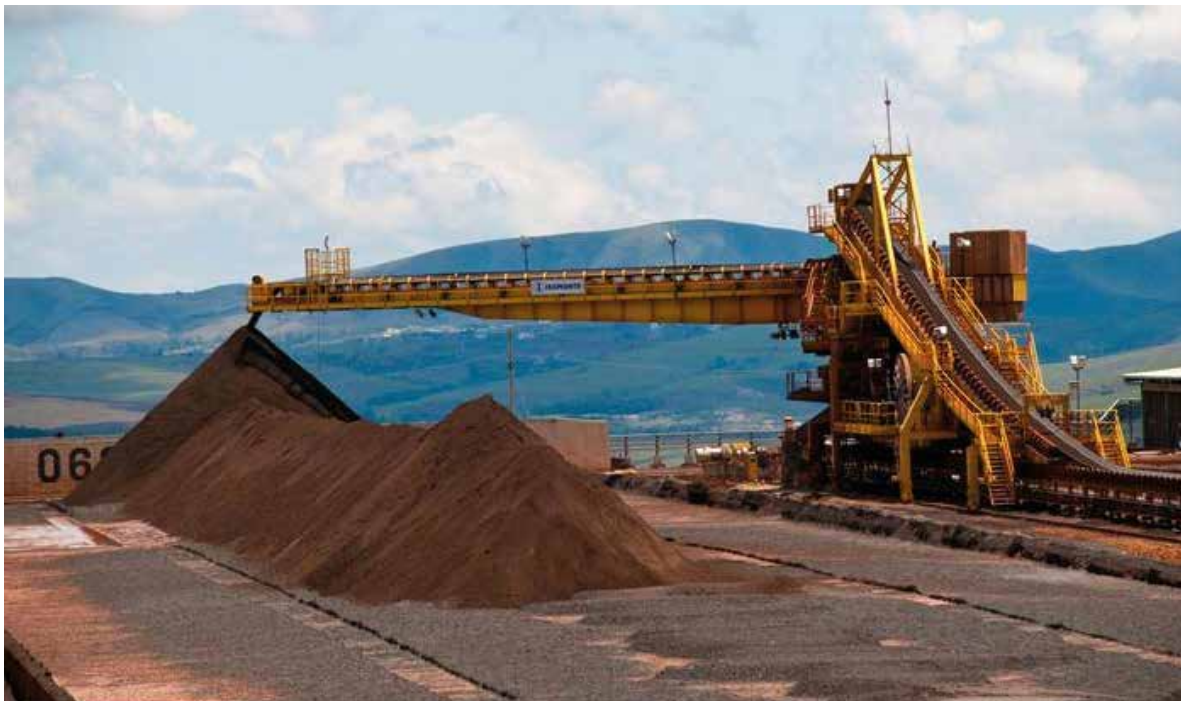
Mineração da Vale em Nova Lima, Minas Gerais
