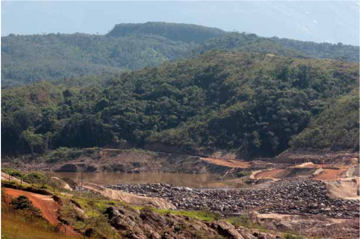
Obras contínuas para contenção da lama em Bento Rodrigues, julho de 2016
